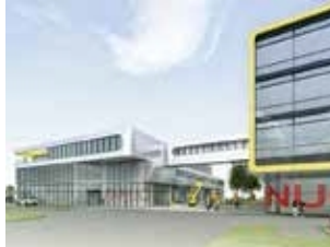
Noch im laufenden Geschäftsjahr wird mit dem Bau eines weiteren Gebäudes direkt neben dem jetzigen Firmensitz in der Bernhäuser Straße begonnen.
