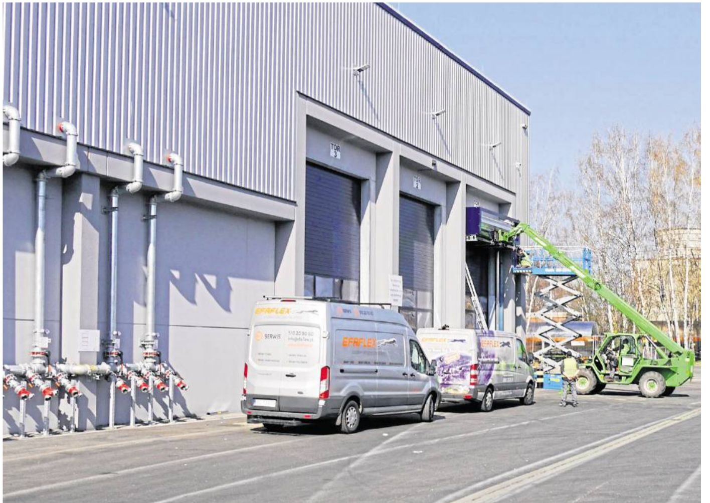
Beim Tag der offenen Tür Ende März war eines der Einfahrtstore zur Sortieranlage Alba im Chemiapark bereits defekt.
